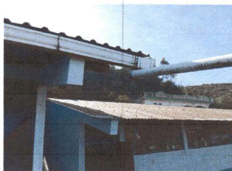
Foto 4: Reparación de bajada de agua pluvial, tubo PVC 3"
