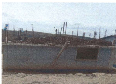
Foto 5: Pintura en muros exteriores e interiores
