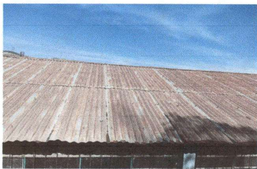
Foto 1: Sustitución de lamina por lamina troquelada
