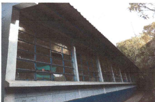
Foto 3: Fabricación e instalación de balcones
