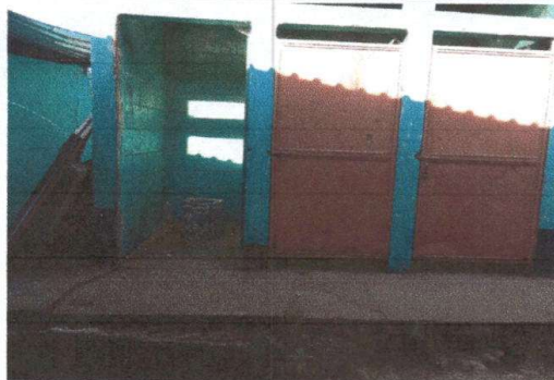
Foto 2: Sustitucion de puerta en servicio sanitario
