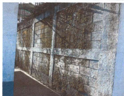
Foto 6: Alisado de muro
